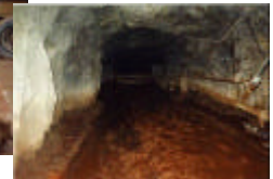
Hienojakoista mutaa louhoksen alla olevassa kaivostunnelissa : Aktiivisuus : 506 000 Bq/kg
